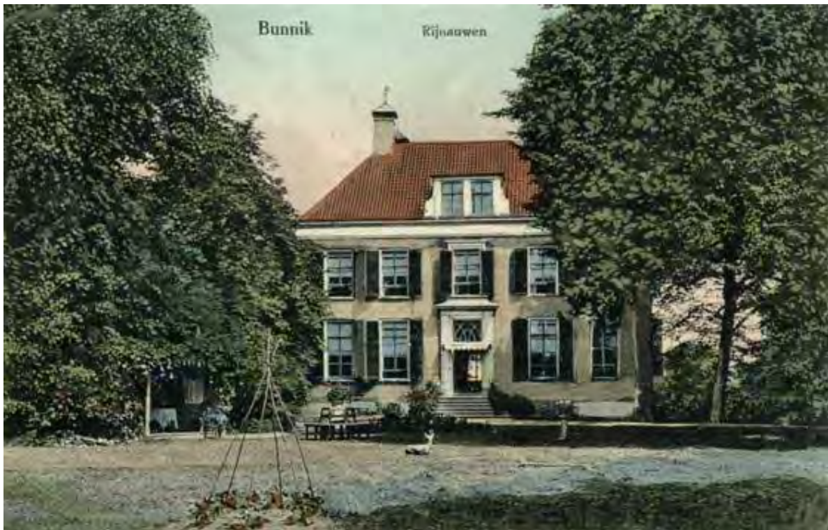
Gezicht op het voorplein omstreeks 1910-1915, met de bestaande linde geplant ca. 1810 (Het Utrechts archief)
