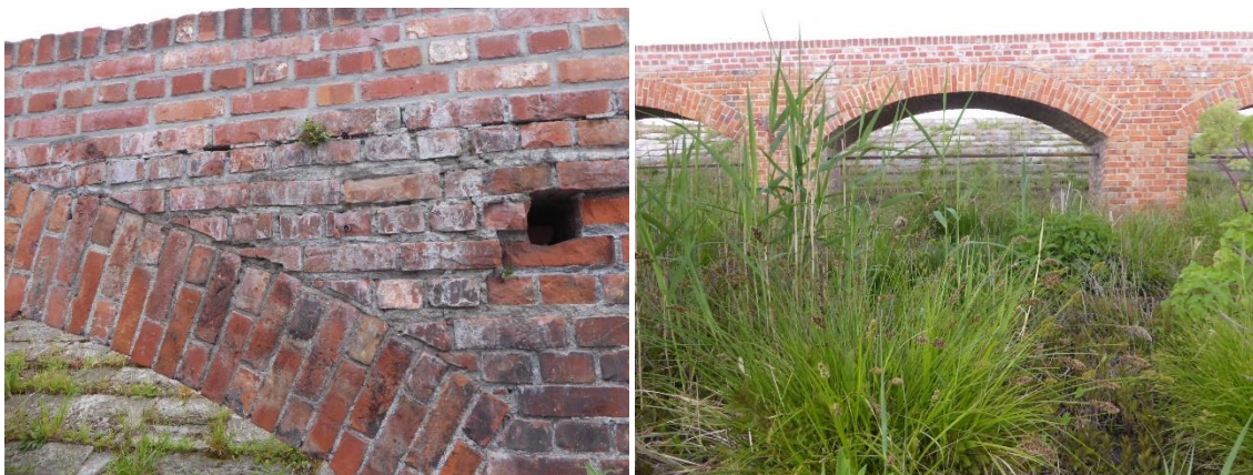
Dichtgevoegde muurdelen kunnen een beter vestigingsmilieu opleveren door het uitfrezen en opruwen van de voegen.
