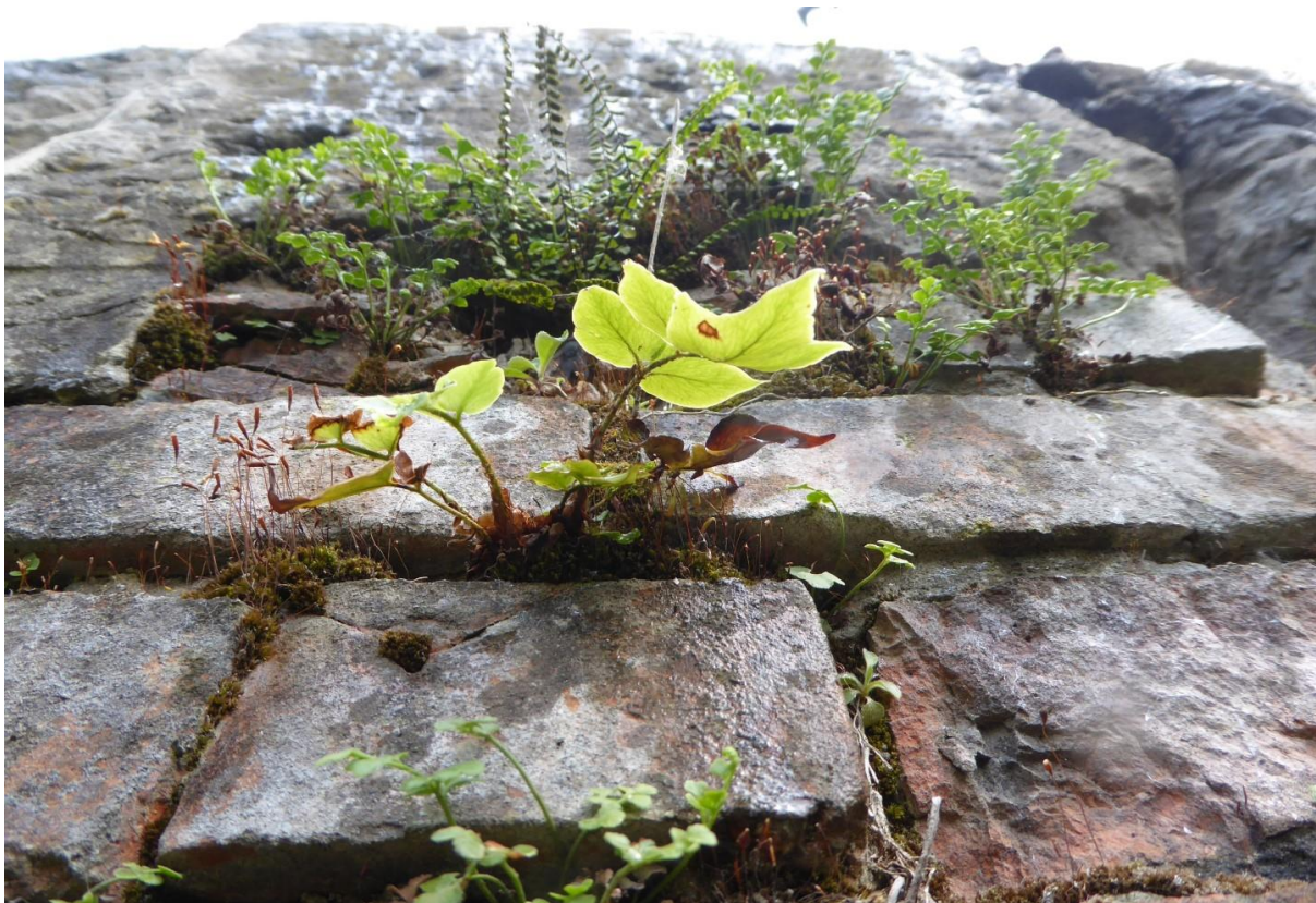
Muurdeel met ijzervaren, muurvaren en steenbreekvaren
