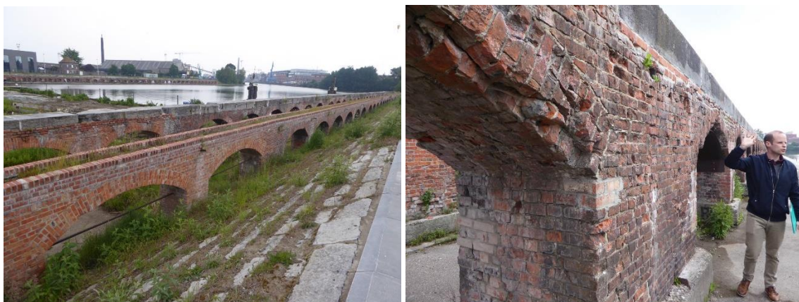
Overzicht houtdokmuren en (rechts) effect van de reiniging.
